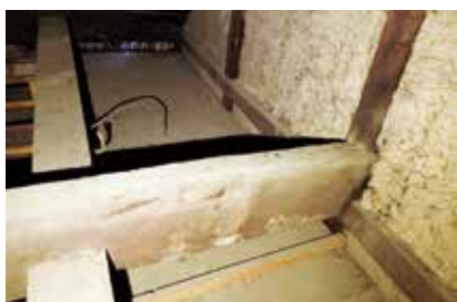
解体部の隣接住戸の小屋裏 梁や棟木、母屋の仕口・接合部（接手）の状況確認。 仕口・接合部（接手）の位置や上下関係によっては構造的な補強が必要となる場合がある。
