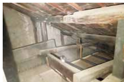
解体部の隣接住戸の小屋裏 梁や棟木、母屋の仕口・接合部（接手）の状況確認。 仕口・接合部（接手）の位置や上下関係によっては構造的な補強が必要となる場合がある。
