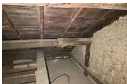
解体部の隣接住戸の小屋裏 梁や棟木、母屋の仕口・接合部（接手）の状況確認。 仕口・接合部（接手）の位置や上下関係によっては構造的な補強が必要となる場合がある。
